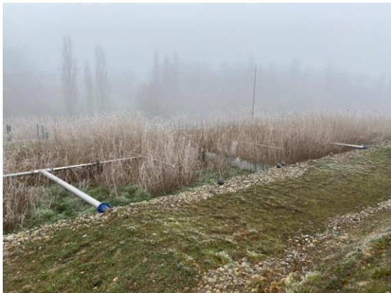
1 er étage de filtres plantés de roseaux
