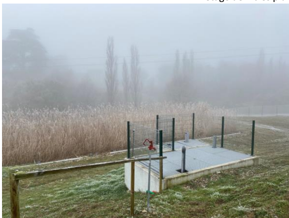
2 ème étage de filtres plantés de roseaux
